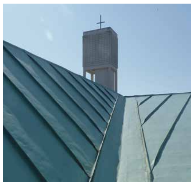
Der blaue Himmel über dem Michaeliszentrum wirkt noch schöner, da das Dach nun repariert ist. Quelle: Pastorin Andrea Schridde
